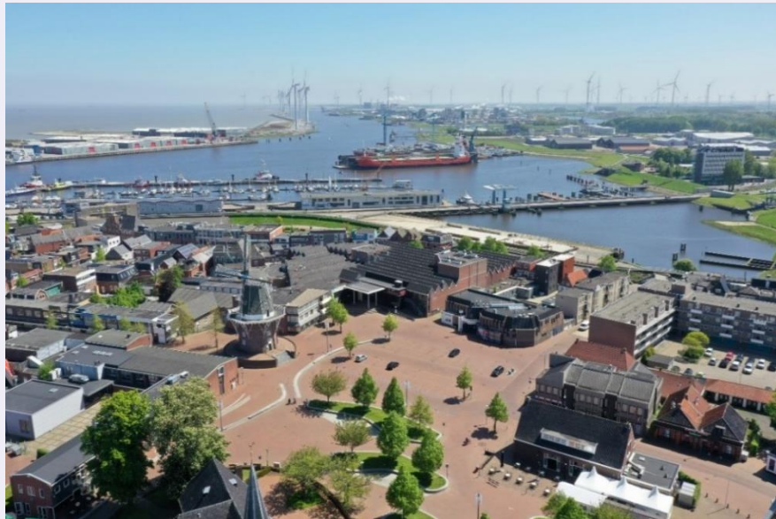
Afbeelding 4 - De huidige situatie aan het Molenbergplein
